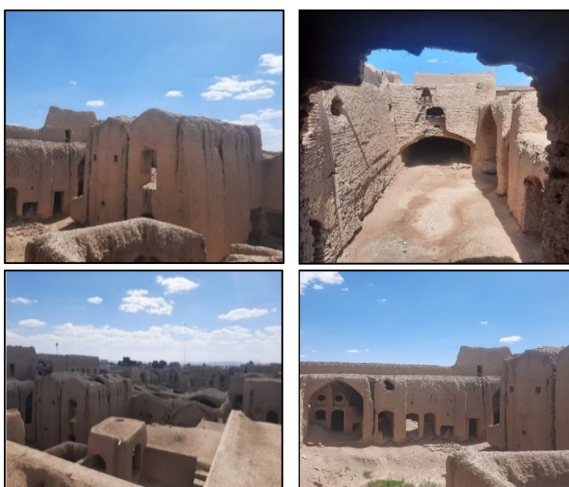
شکل ۴: ایجاد شیار فرسودگی در بدنه و جای شیار به خاطر تغییر عملکرد ناودان ها
