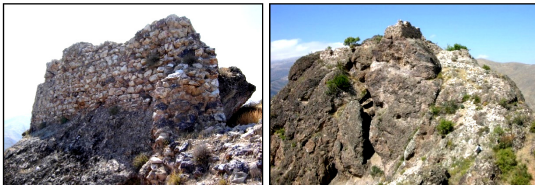
شکل ۴. راست، بخش غربی قلعه جوگرگان، دید از شرق؛ چپ؛ بخشی از دیوار سنگی بخش غربی قلعه (نجفی، ۱۳۸۶) Figure 4. Right, western part of Jojargan Castle, view from the east; left; Part of the stone wall of the western part of the castle (Najafi, 2007)
