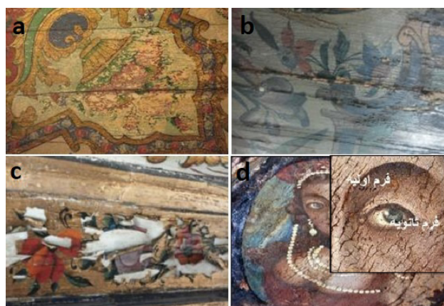
شکل ۱. جدایش لایه رنگ خانه زینت‌الملک (a)؛ ترک‌های نواری خانه صبار (b)؛ ترک‌های کاسه‌ای خانه صبار (c)؛ ترک‌های شبکه‌ای خانه محتشم (d)
