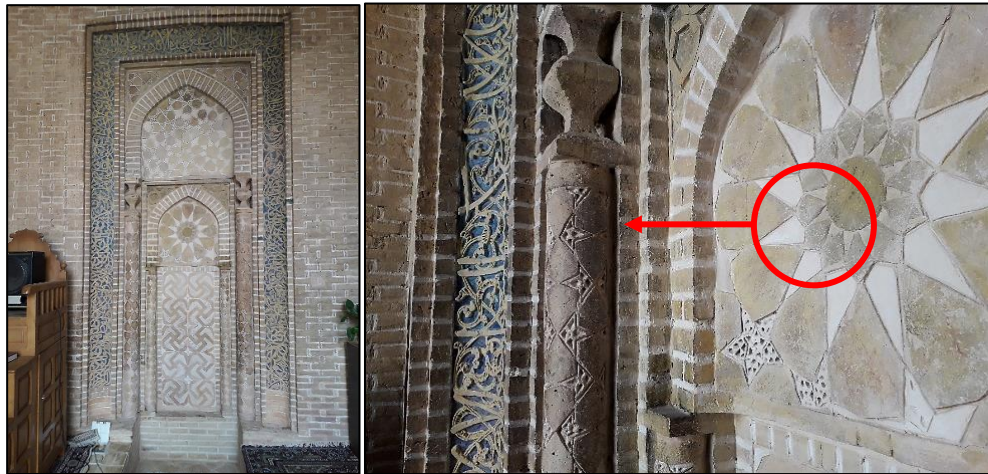
شکل ۵. محراب مسجد سین با تلفیق آرایه‌های آجری و آرایه‌های گچی برجسته و نقش‌گود.
