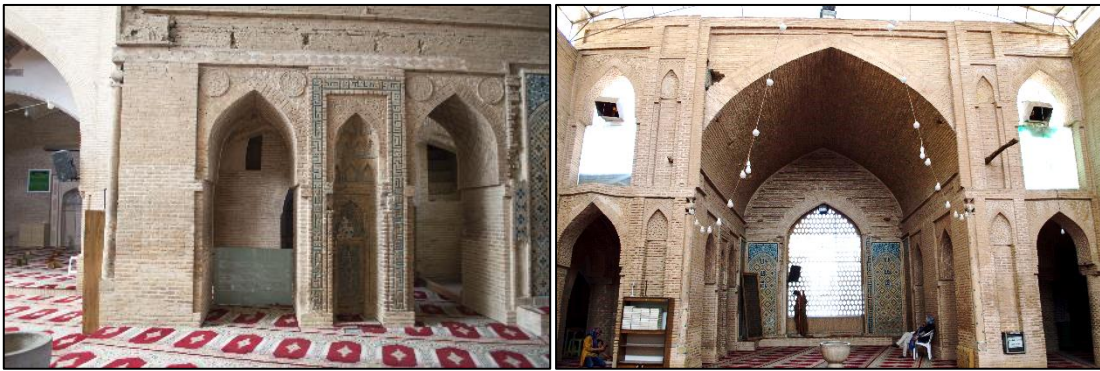
شکل ۶ ایوان شمال غربی مسجد جامع گز که شواهدی از دو دوره تاریخی دارد. آرایه‌های معماری: تلفیق آرایه‌های آجری، گچی و کاشی.
