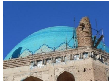
شکل ۳: گنبد سلطانیه و نمای شرقی بنا
