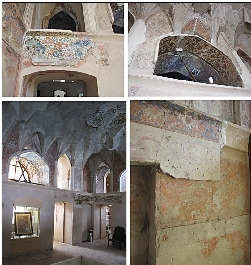
شکل ۲: لایه‌چینی و طلاکاری در لایه‌های مختلف آرایه معماری در عمارت چهل‌ستون قزوین Fig. 2: Pastiglia and gilding in different layers of architectural arrangement in Qazvin chehelstoun
