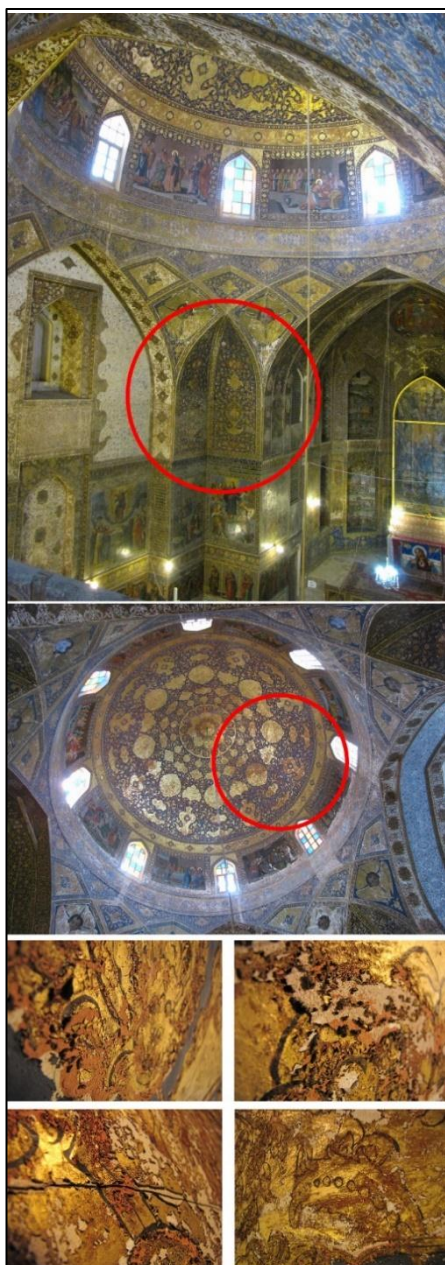
شکل ۱: مجموعه تصاویر کلیسای بیت‌لحم. تصویر بالا: محل نمونه‌برداری نمونه 2016.B.2، تصویر وسط: محل نمونه‌برداری نمونه 2010.B.1، چهار تصویر پائینی: لایه‌چینی‌های آسیب‌دیده، قبل مرمت.
