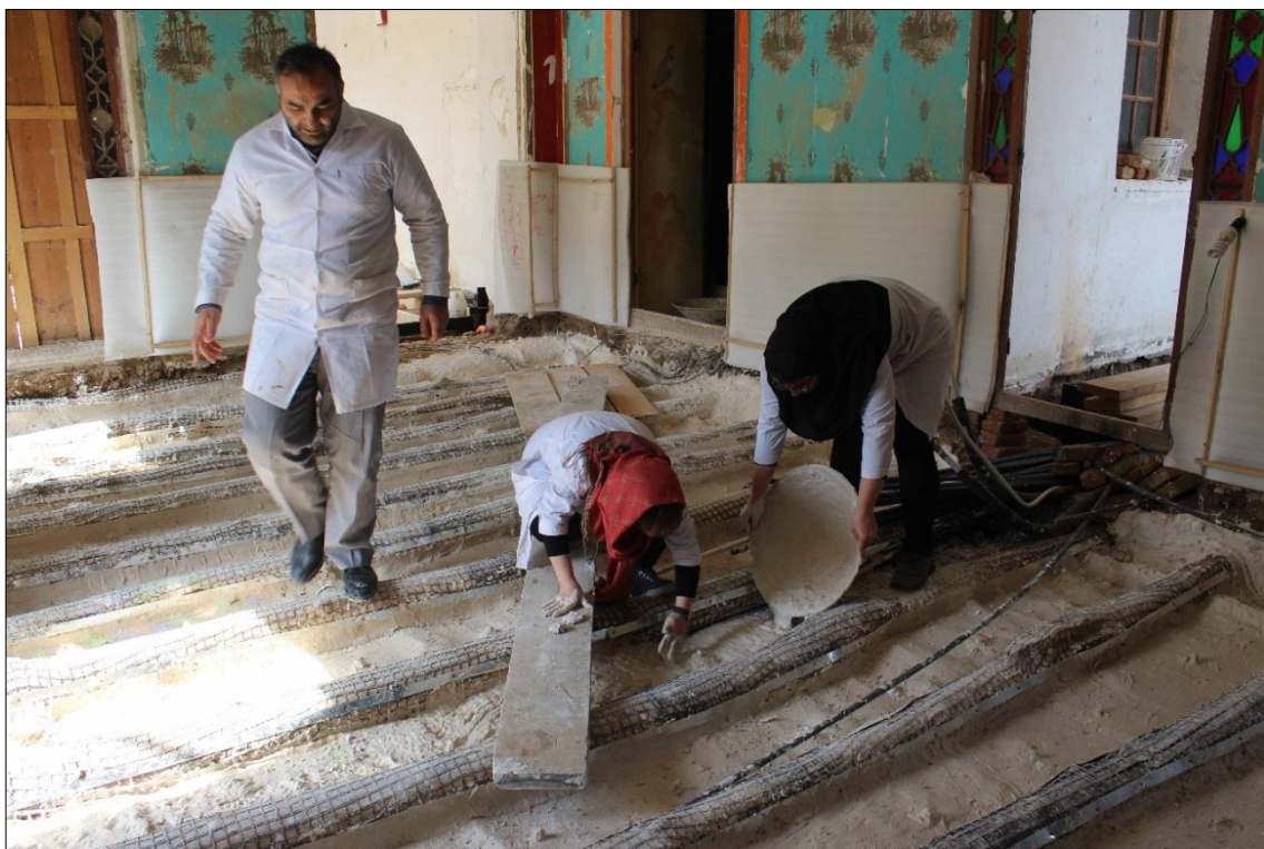
شکل ۳: اجرای تخته گچی در بین تیرپوش‌های سقف اتاق سفره‌خانه عمارت سردار ماکو
