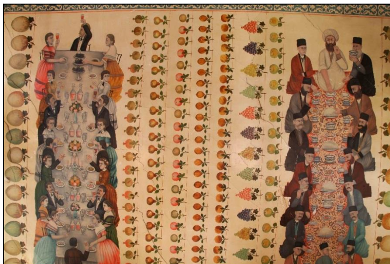
شکل ۱: نقاشی‌های سقف اتاق سفره‌خانه که آسیب‌های ترک، طبله باعث جدایی لایه اجرایی گردیده است
