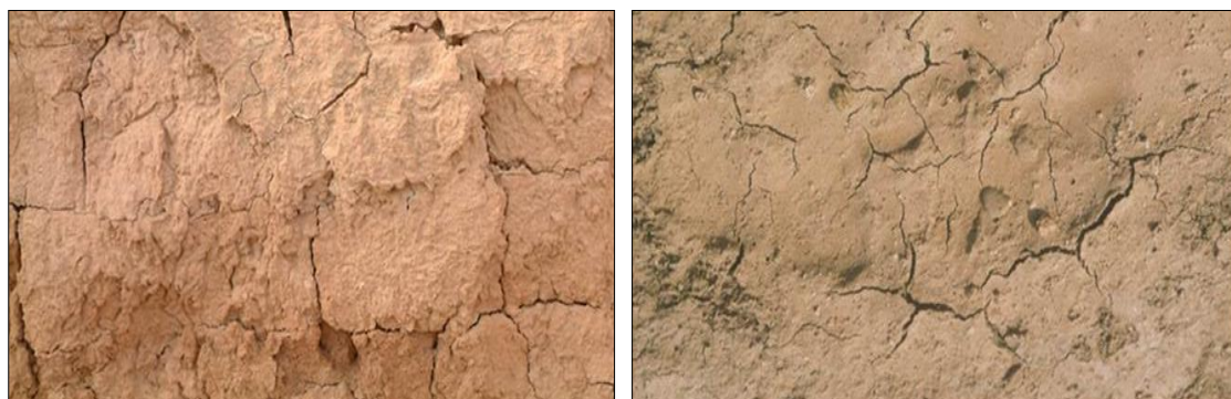
شکل ۶: نمونه‌ای از الگوهای ترک‌خوردگی خشت‌ها
