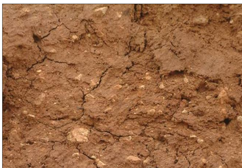
شکل ۳: نمونه‌برداری و بررسی خصوصیات ماکروسکوپیک خشت‌های محوطه ارگ بم Fig. 3: Sampling and investigation of the macroscopic properties of the adobes of the Arg-e Bam site
