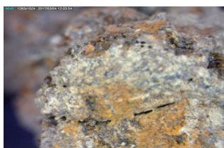
شکل ۱۸. ترک موازی با سطح
