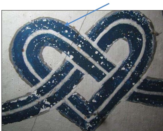
تصویر ۱۸. نمونه رنگ سبز تیره زیر لوپ پس از حرارت
