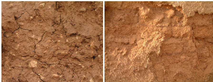
شکل ۴: خشت‌های ناهمگن و همراه با خرده آجر
