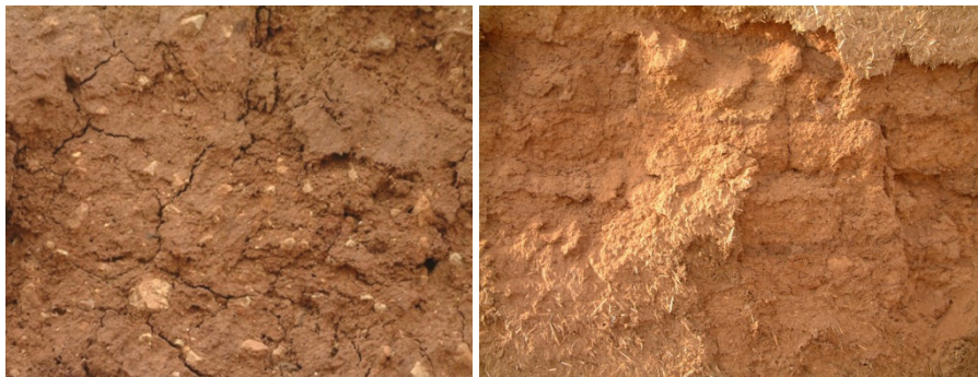
شکل ۴: خشت‌های ناهمگن و همراه با خرده آجر
