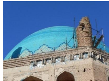
شکل ۳: گنبد سلطانیه و نمای شرقی بنا
