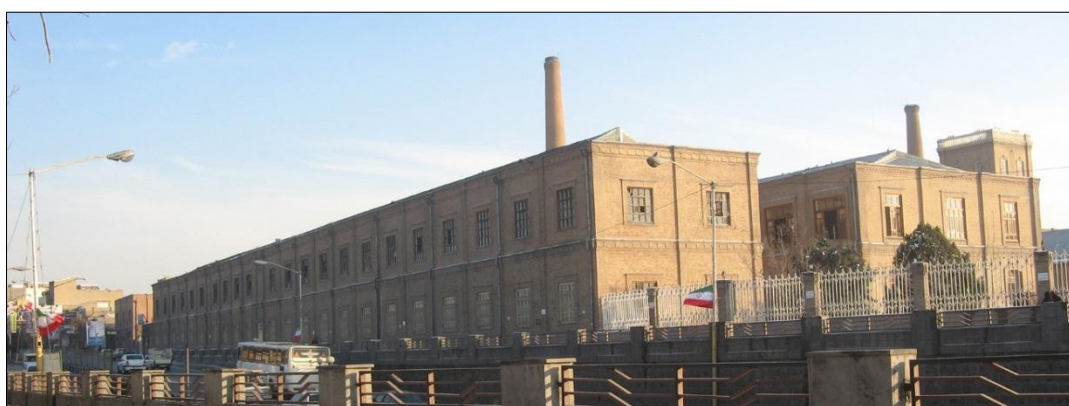
شکل ۳: ساختمان شماره ۱ آموزشی مجموعه چرم‌سازی- نمای شمالی و غربی Fig. 3: No.1 Educational heritage building of Charmsazi Complex-West and North façade
