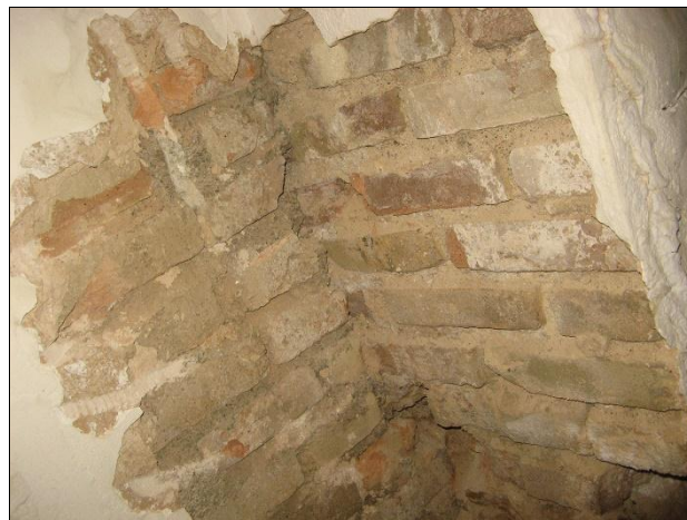
شکل ۶: مصالح بنایی اصلی و تاریخی بنای موردنظر (ابعاد هر آجر ۲۰×۱۰×۵ است) Fig. 6: Schematic of main masonry material used in building (brick dimension: 20×10×5 cm)
