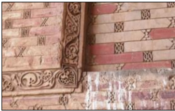
شکل ۵: آرایه‌های گچی در ایوان جنوب غربی بیرونی بنای گنبد سلطانیه
