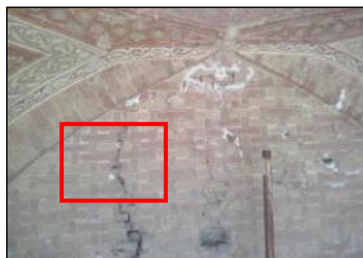
شکل ۶: محل نمونه‌برداری آرایه‌ها از بدنه ایوان بیرونی ضلع جنوب غربی
