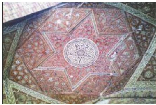
شکل ۴: آرایه‌های گچی در ایوان جنوب غربی بیرونی بنای گنبد سلطانیه
