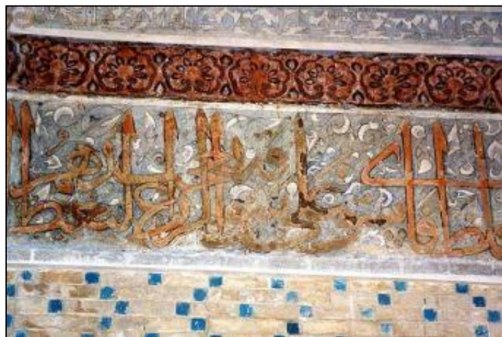
شکل ۱: آرایه‌ها و کتیبه‌های گچی رنگ‌آمیزی شده فضای داخلی گنبد سلطانیه Fig. 1: Decorative gypsum inscriptions with colorful decorations
