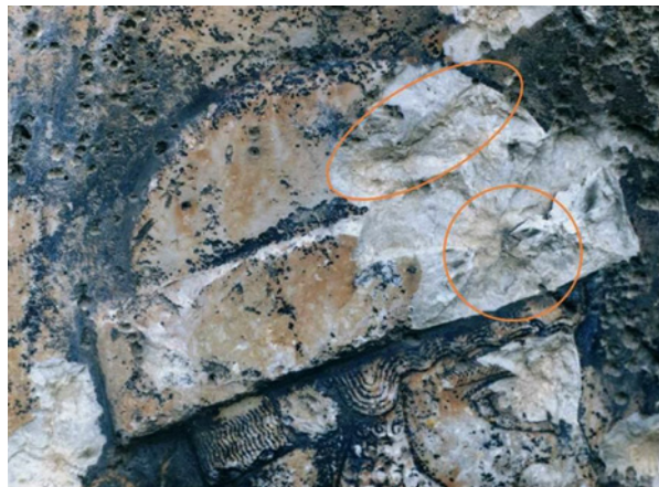
شکل ۱۵. هوازدگی بیوشیمیایی در محل اصابت گلوله‌ها Figure 15. Biochemical Weathering at Bullet Impact Sites
