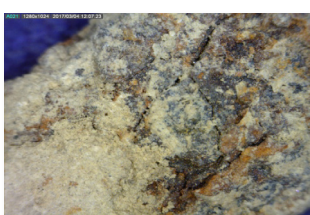
شکل ۱۷. ریزترک‌های موجود در سطح Figure. 17. Microcracks on the surface
