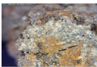
شکل ۱۸. ترک موازی با سطح
