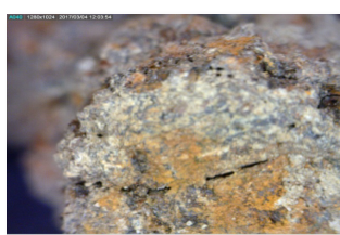
شکل ۱۸. ترک موازی با سطح
