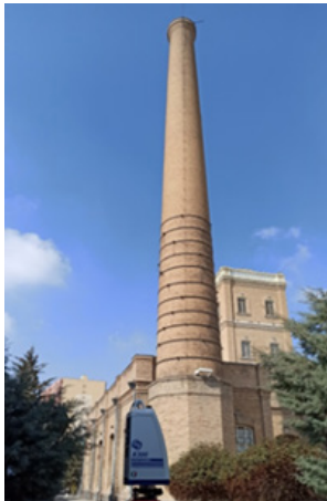
شکل ۷. محل قرارگیری دستگاه در برداشت‌های متعدد دودکش کارخانه چرم خسروی
