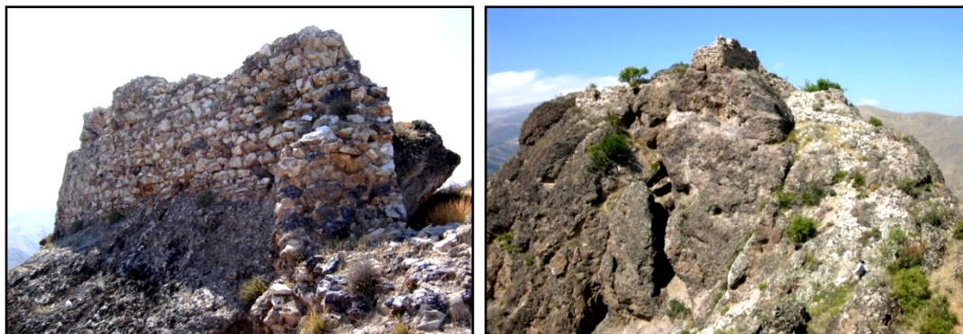
شکل ۴. راست، بخش غربی قلعه جوجرگان، دید از شرق؛ چپ، بخشی از دیوار سنگی بخش غربی قلعه (نجفی، ۱۳۸۶) Figure 4. Right, western part of Jojargan Castle, view from the east; left; Part of the stone wall of the western part of the castle (Najafi, 2007)
