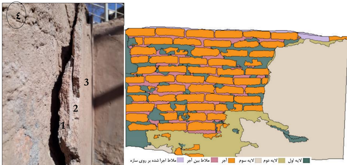
شکل ۵: لایه‌های اندود مورد مطالعه در سازه موسوم به سقابه ربع رشیدی، مشخص شدن محل نمونه‌های مطالعاتی ۱ الی ۴
