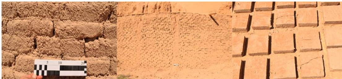
شکل ۳: فرسایش خشت‌ها و ساختار دیوارها در محوطه تاریخی بلقیس
